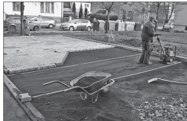
FOTOGRAFIE ZACHYCUJE realizaci odstavných parkovacích stání. V současné době jsou už práce ukončeny a parkovací stání plní svou funkci.
